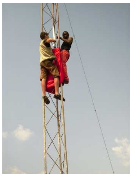
installazione punto wi-fi 360°
